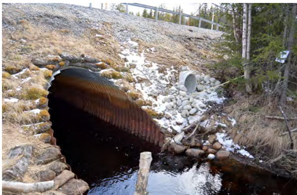
Bild 8. Torrtrumma anlagd bredvid rörbro (ID 97, Långbäcken). Trumman har används flitigt av olika djur.
