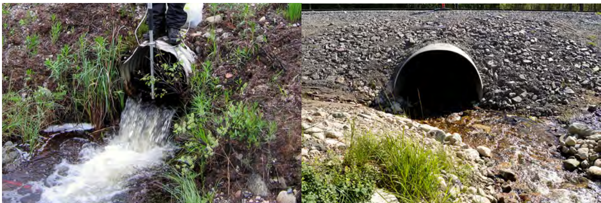
Bild 3. Bilden till vänster visar en trumma där det är hög vattenhastighet och ett fall har bildats vid utloppet. Till höger visas samma objekt efter åtgärd där en större trumma med bottenmaterial har anlagts (ID 54).
