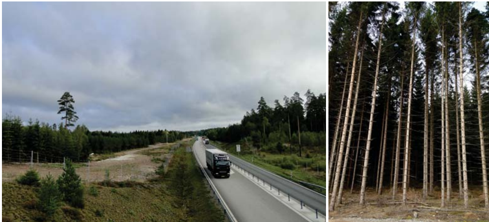
Figur 2-6. Delsträcka C. Vy mot norr. Sydvästlänken har grävts ner i nära anslutning till E4:an längs stora delar av vägsträckningen och har en stor visuell påverkan på vägmiljön. Bild t.h: Inre delar av skogsbestånden blir skogens nya gräns i och med avverkning för kraftledningsgata.
