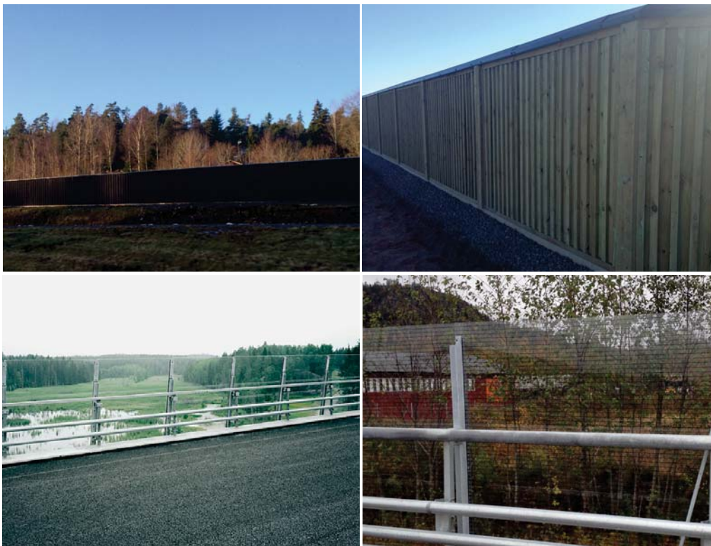
Figur 3-29. Exempel på träskärm och transparent skärm. Används som vägledning för utformning av bullerskärmar längs vägsträckan. Foto till ovan t.v. Rasmus Norlander, projekt väg 73.
