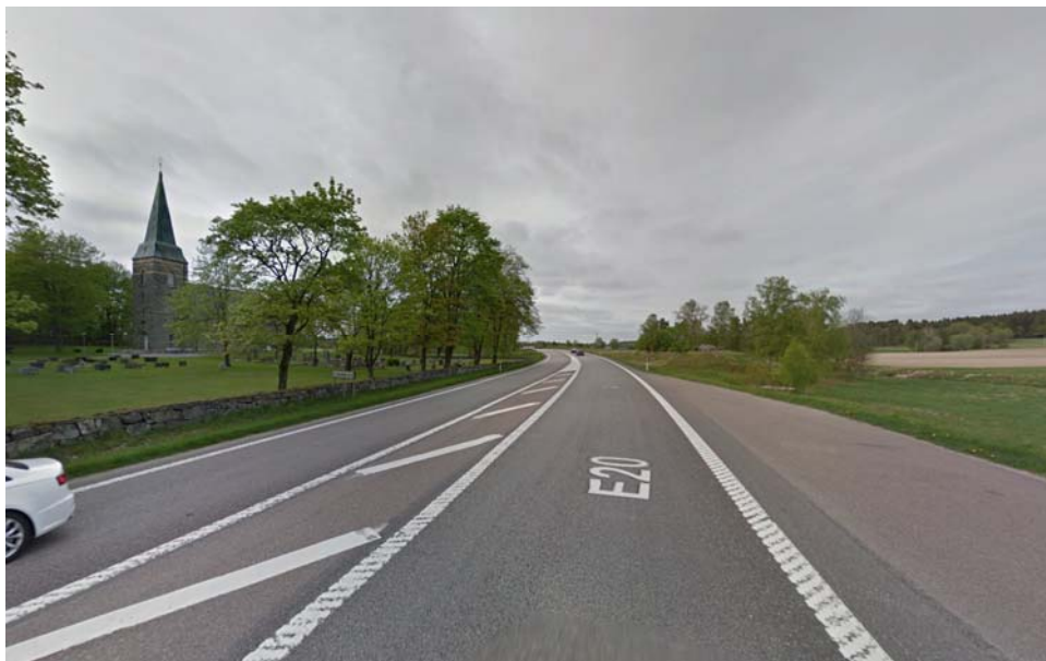
Figur 2.2:1 Nuvarande väg E20 söderifrån vid Hären kyrka. Källa: Google Maps.
