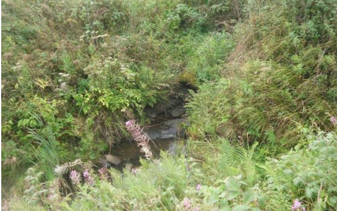
Figur 31. Objekt 15. Öppet dike med 1-2 meter bred vattenfåra.
