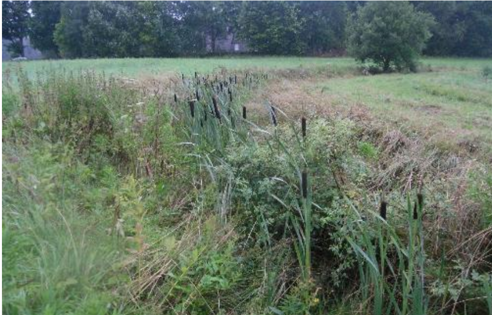
Figur 33. Objekt 16. Öppet dike genom åkermark.
