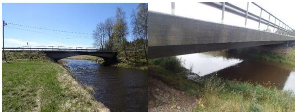
Figur 4.6.4:3 Vänster: Befintlig bro över Nossan vid Södra Härene kyrka väg Höger: Bro över Nossan sv Ribbingsberg
