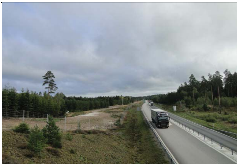
Figur 5-3. Sydvästlänken har grävts ner i nära anslutning till E4 längs vissa delar av vägsträckningen. Foto: Treeline AB
