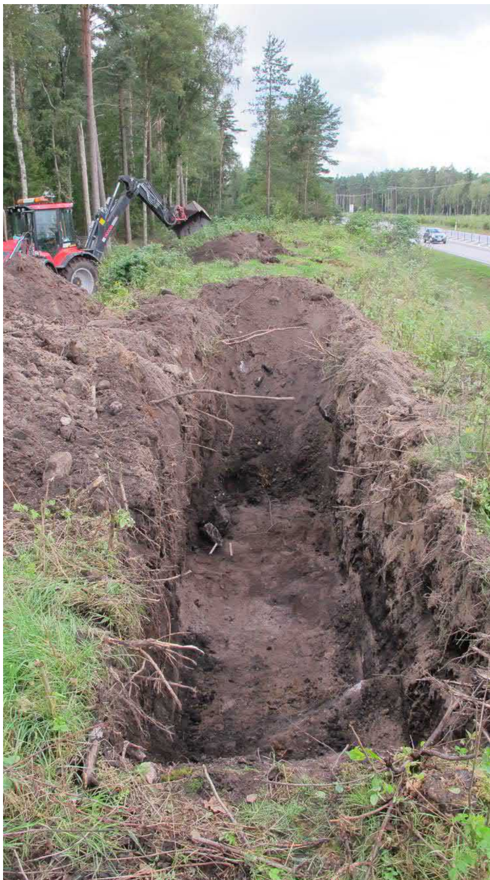
Figur 9. Den bitvis upp till ca 1,7 meter tjocka vallen med upplagda massor vid Objekt 7. Foto mot söder.
