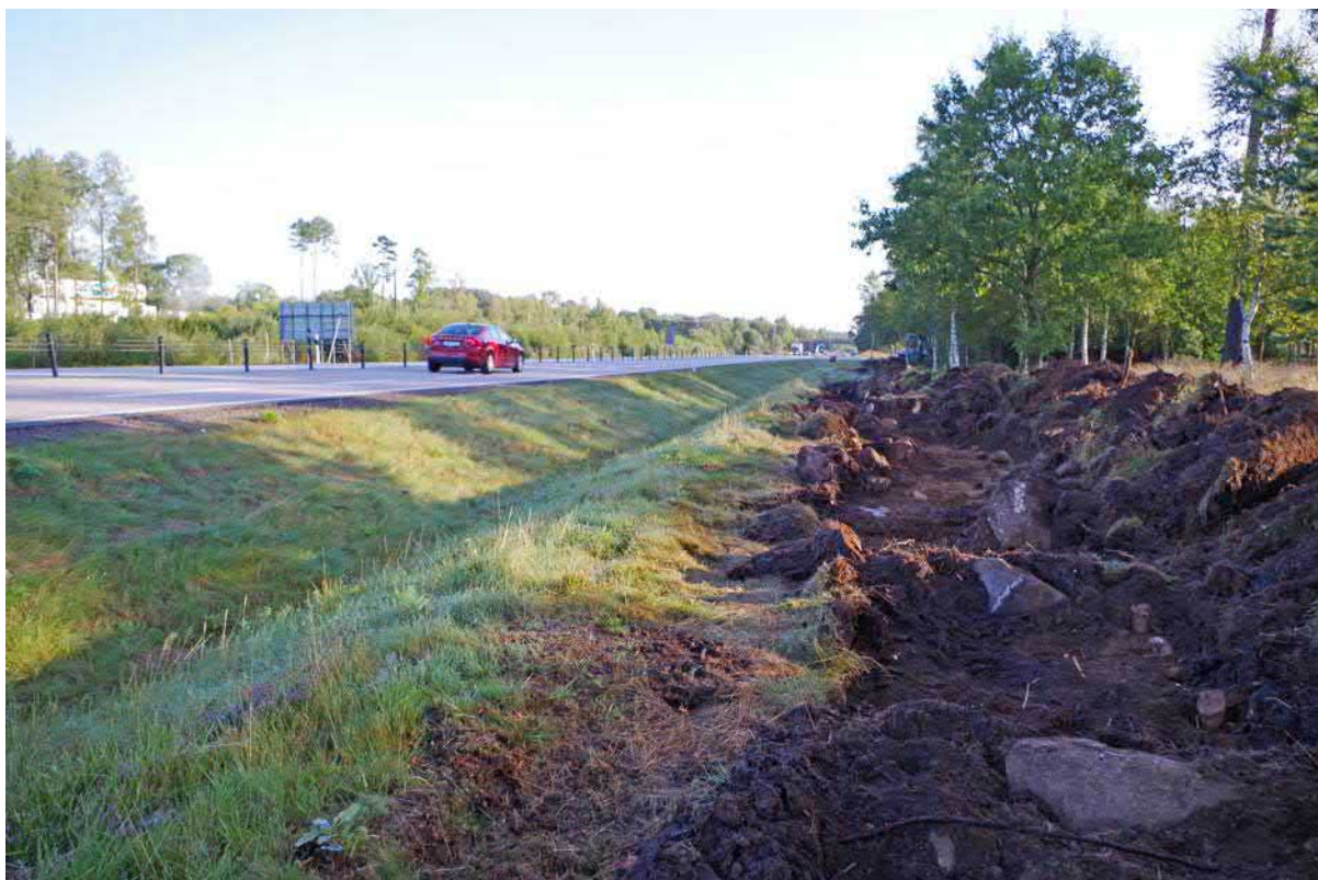
Figur 14. Den stembundna marken inom Objekt 9 vid schaktning. Foto mot norr.
