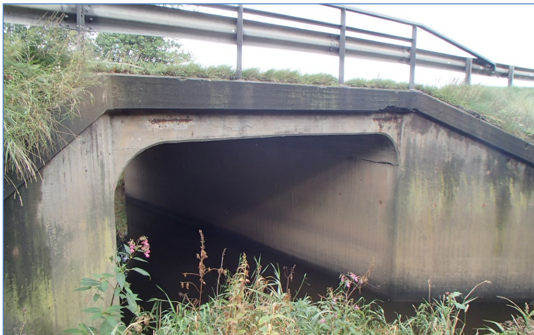
Figur 5. Bron över Afsåns södra fåra. Foto från BatMan.
