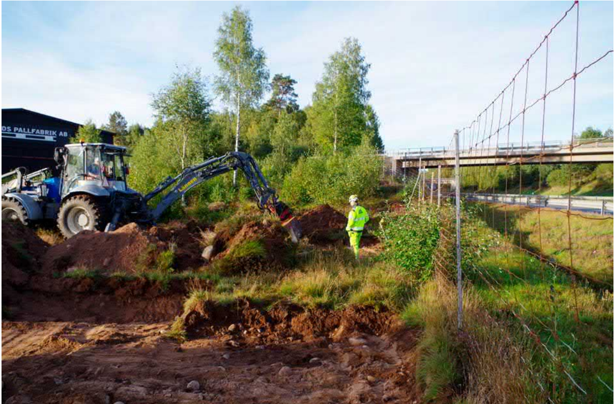
Figur 5. Schaktning i södra delen av RAÄ 348. Foto från norr.
