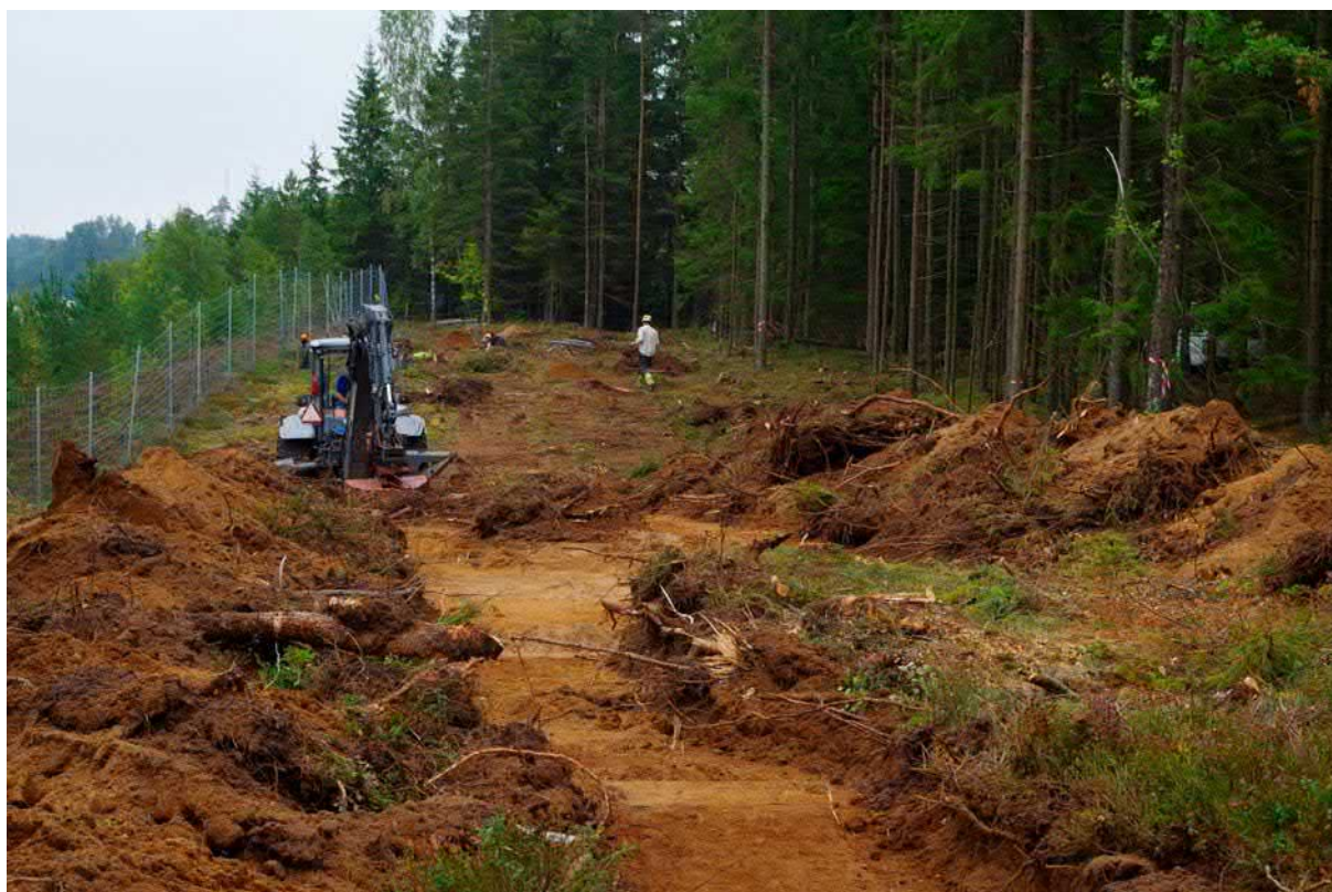
Figur 19. Schaktning inom undersökningsområdet. Foto från söder.
