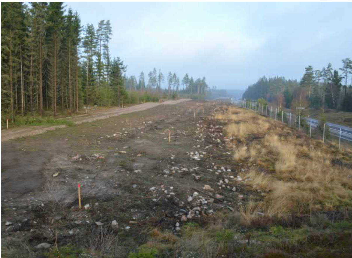
Figur 1. Bilden visar arbetsområdet för Sydvästlänken i anslutning till det fossila åkermarksområdet RAÄ Kånna 65:1. I detta fall är bredden på själva markarbetet ca 28 meter och området mellan Sydvästlänken och väg E4 yttre vägbana är ca 15 meter. Inom dessa 15 meter utgörs ca hälften av väggren, vägdike och släntning. Utifrån en tänkt arbetsbredd på 50 meter kvarstår således ca 15 meter av oexploaterad mark varav ca 7-8 meter ligger inom RAÄ Kånna 65:1.
