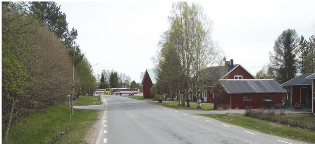
Figur 3.2.1. Väg 582 genom Alvik saknar gång- och cykelvägar, har smala vägrenar och bebyggelsen ligger nära vägen.
