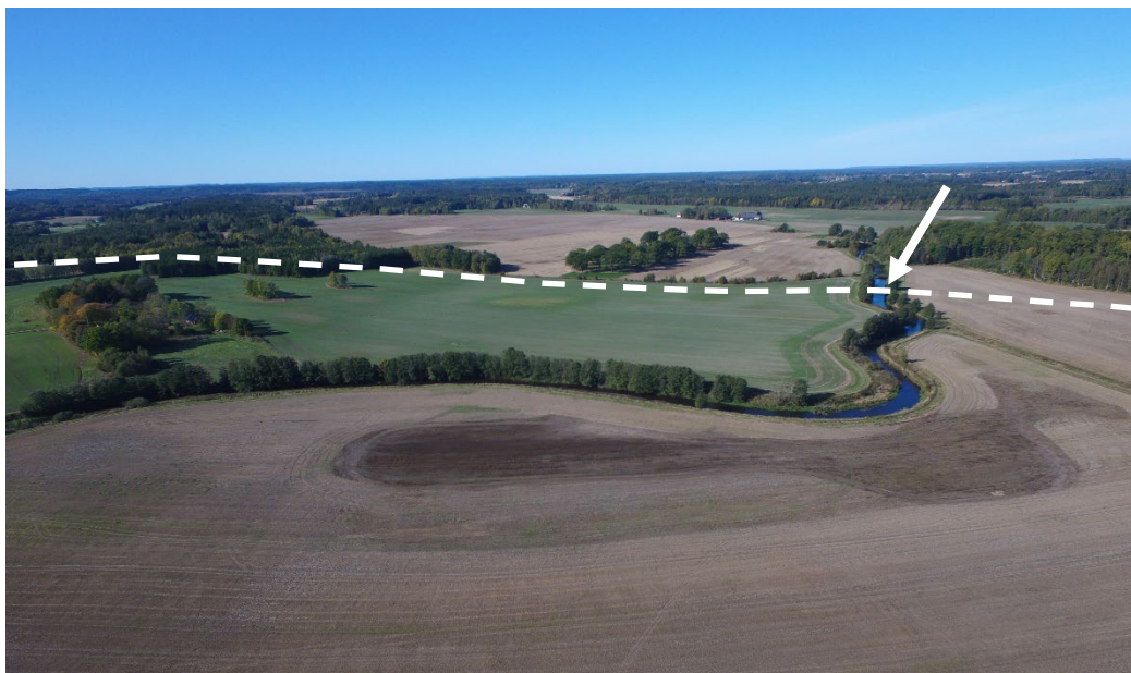
Figur 3.1 Landskapet kring Nossan vid läget för ny E20-bro (vid pilen). Linjen illustrerar vägens planerade sträckning. Foto Veidekke Entreprenad AB.
