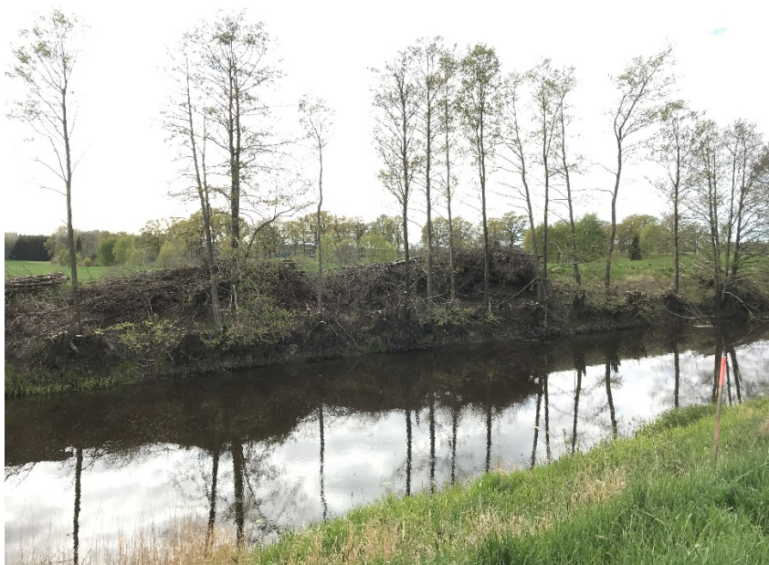
Figur 3.3 Nossan vid platsen för den nya bron.
