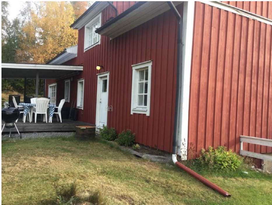
Bild visar fasad som vetter mot väg.
