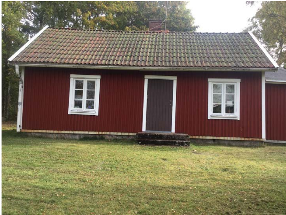
Bild visar fasad som vetter mot väg.
