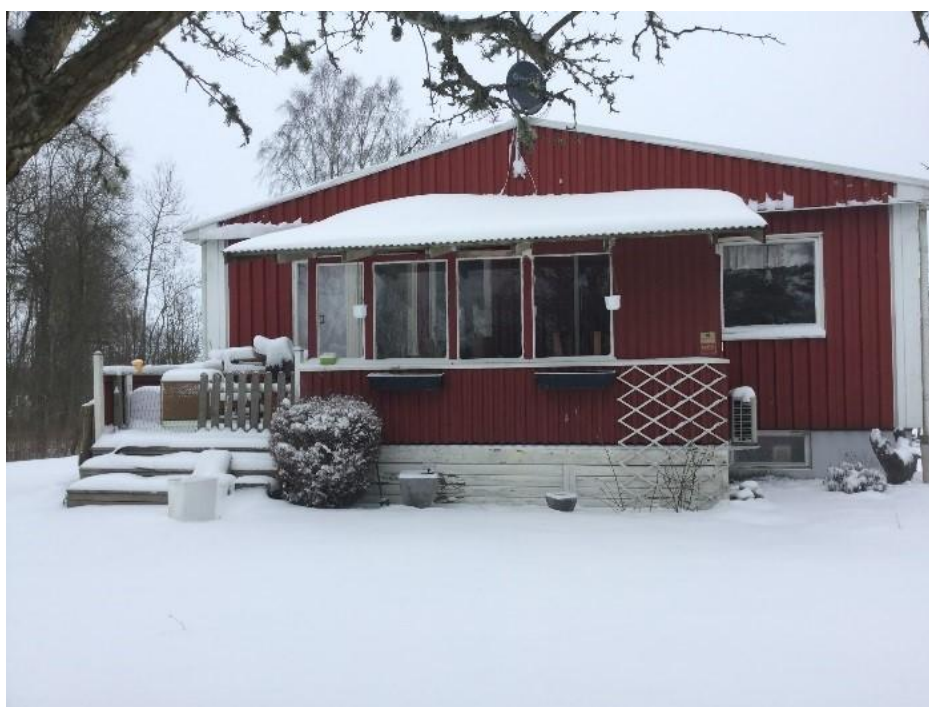
Bild visar fasad som vetter mot väg.
