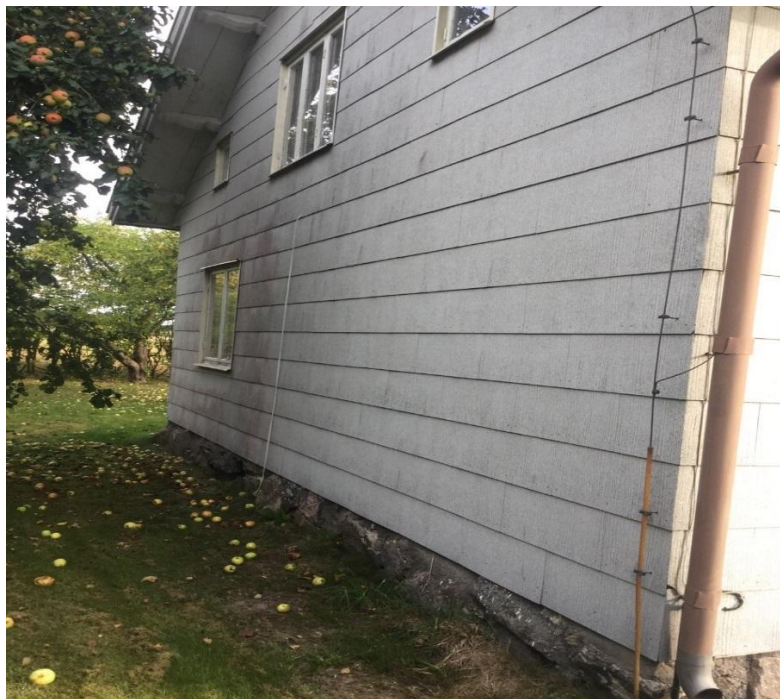
Bild visar fasad som vetter mot väg.
