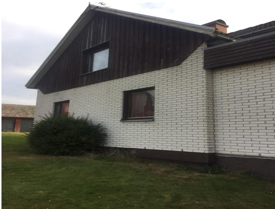
Bild visar fasad som vetter mot väg.
