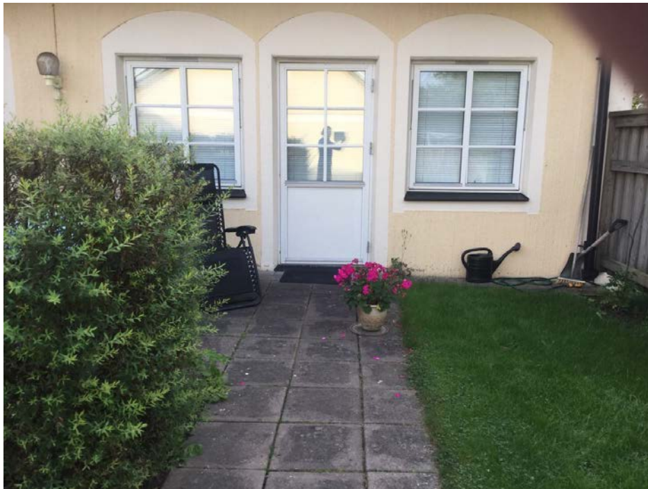
Bild visar fasad som vetter mot väg.
