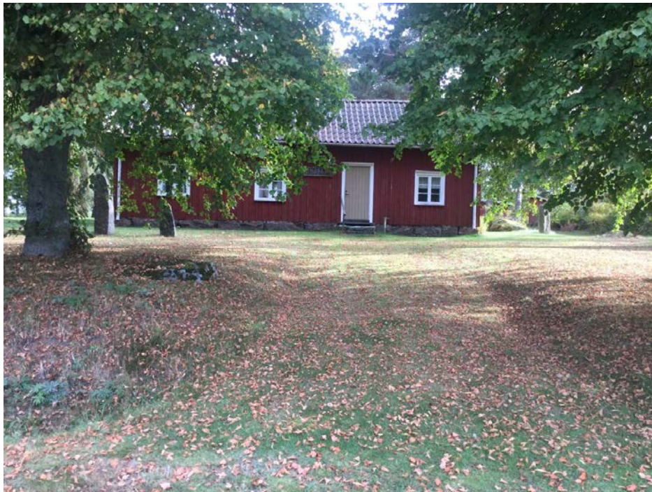
Bild visar fasad som vetter mot väg.
