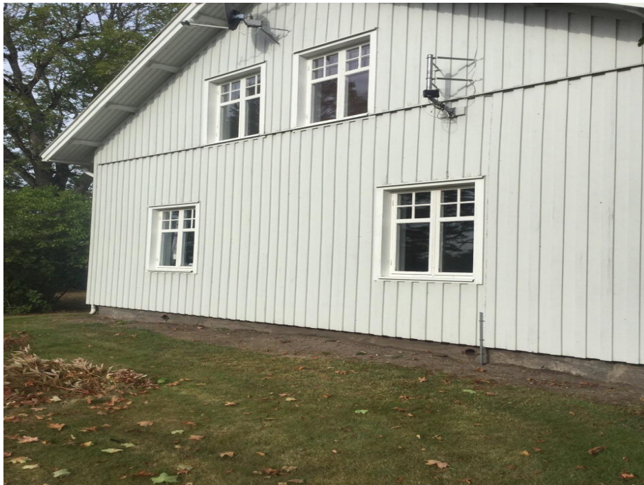
Bild visar fasad som vetter mot väg.
