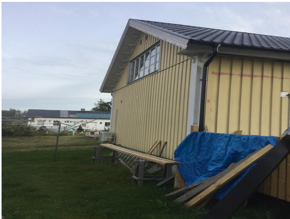
Bild visar fasad som vetter mot väg.
