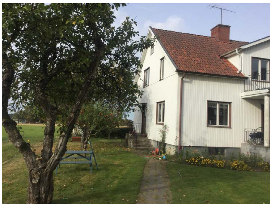
Bild visar fasad som vetter mot väg.
