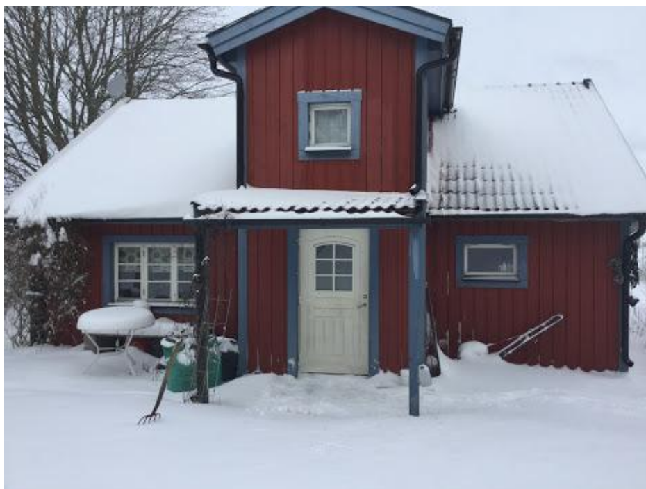
Bild visar fasad som vetter mot väg.
