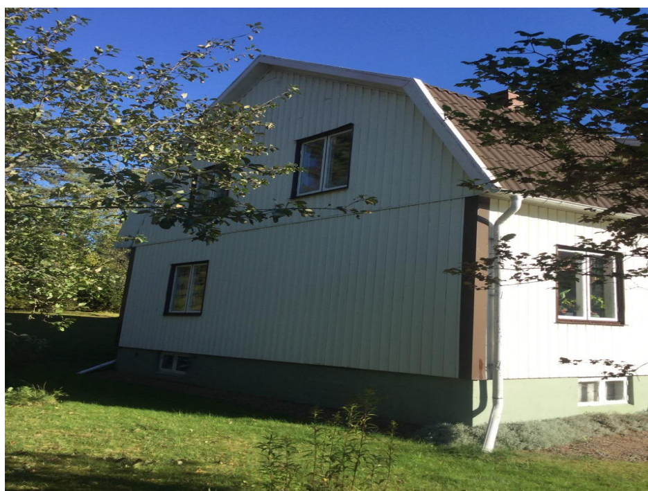
Bild visar fasad som vetter mot väg.
