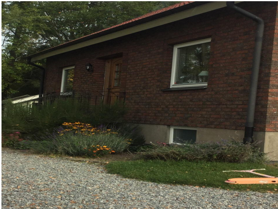
Bild visar fasad som vetter mot väg.
