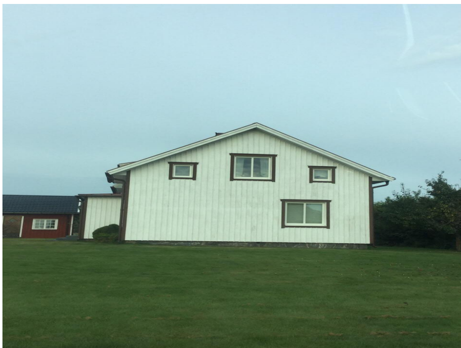
Bild visar fasad som vetter mot väg.
