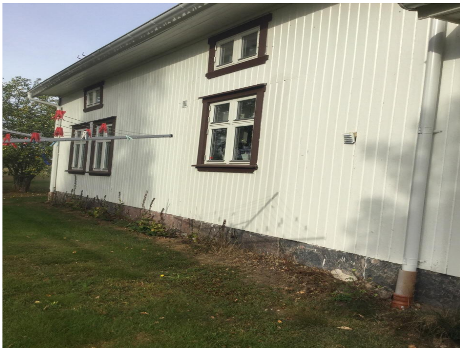
Bild visar fasad som vetter mot väg.
