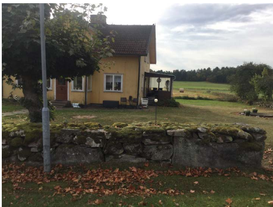
Bild visar fasad som vetter mot väg.
