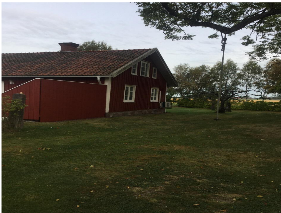
Bild visar fasad som vetter mot väg.
