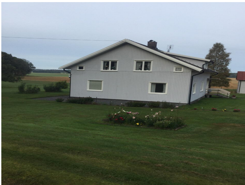
Bild visar fasad som vetter mot väg.
