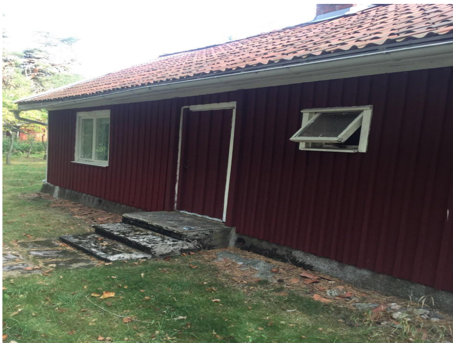
Bild visar fasad som vetter mot väg.
