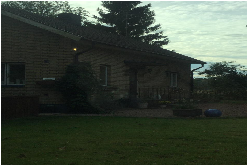
Bild visar fasad som vetter mot väg.
