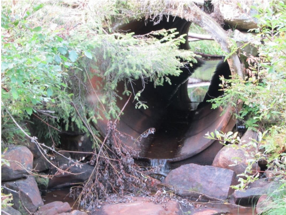
Figur 6. Vägrumma vid Dönträskbäcken, som uppvisar vandringshinder i form av fall på nedströmssidan.
