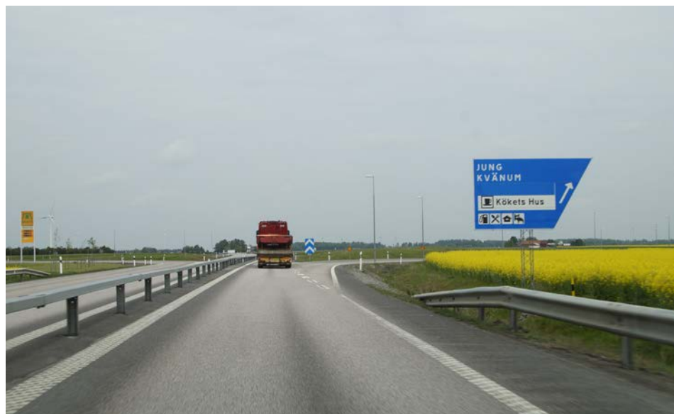
Bild 8. Den storskaliga slätten norr om Vara bevaras tack vare att sekundärvägen förlagts under E20.
