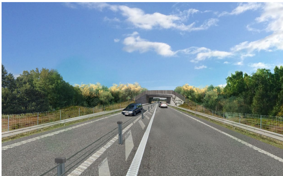
Figur 23. Exempel på utförande av faunapassage.
