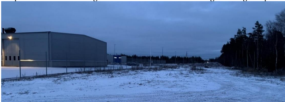
Figur 4.5.13 Scantias byggnad i utredningsområdets sydöstra kant. (FP 12)
