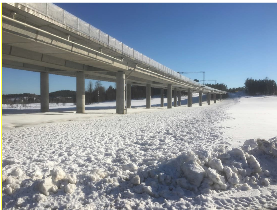
Figur 3: Ytavlopp: Trafikverkets bild
