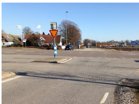
Figur 15 Passage Väståkravägen, vy mot väg 852.
