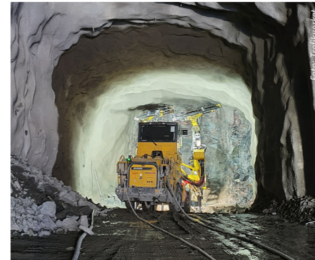
Borriggen Kajsa borrar för salva inne i Södra vägens östra arbetstunnel.
