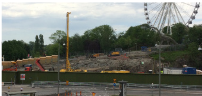
Vi startar schaktarbetet på den östra sidan av Korsvägen, här kommer sedan den östra uppgången att ligga. Foto: Trafikverket
