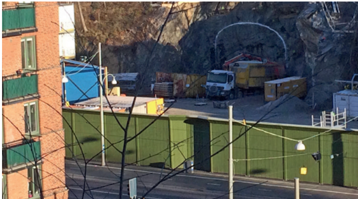
Den vita böjda linjen på berget markerar tunnelmynningen. Vi har tidigare sprängt för att skapa en lodrät yta och i december startar sprängning för arbetstunneln som ligger på den östra sidan av Södra vägen. FOTO: TRAFIKVERKET
