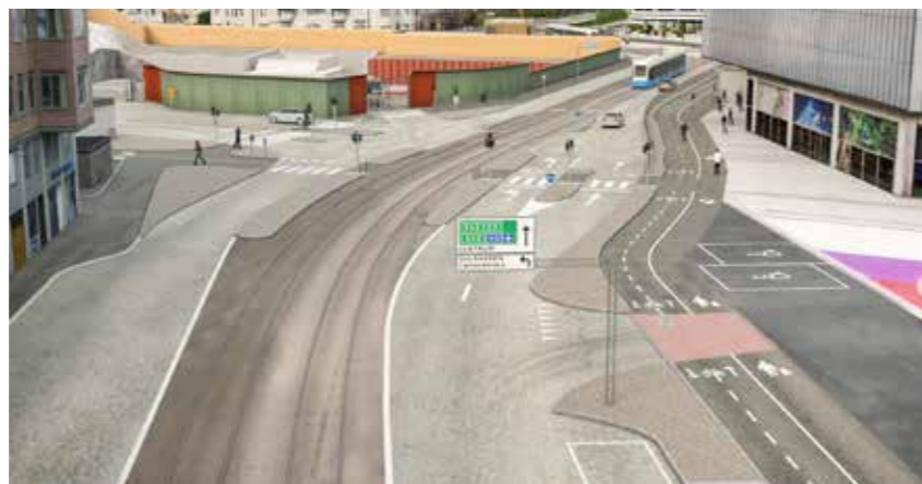
Korsvägen från söder. Cykelbanan går förbi Universeum, vidare på bron över schaktet. Nu går det också att svänga upp mot Eklandagatan när du kör från Mölndalshållet. Bilde: Trafikverket
