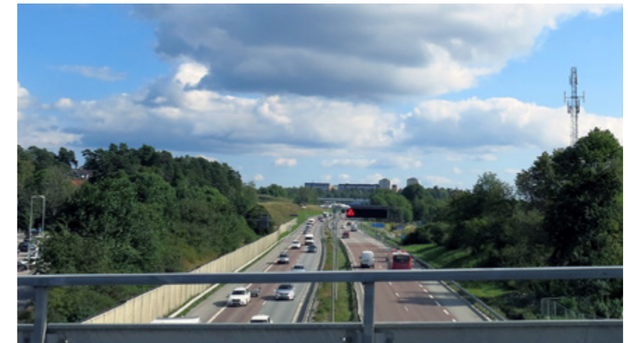
Befintlig bullerskyddsplank och bullerskyddsvall på den östra sidan av E18.
