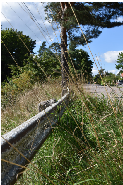
Räcke och milsten utmed gamla Enköpingsvägen.
