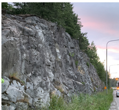
Bild 21. En brant bergskärning eftersträvas
