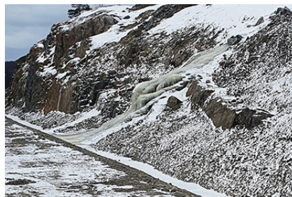
Bild 18. Kärnor eller klackar av berg bevaras för att skapa variation i slänten.
