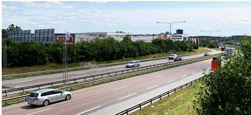
Bild 5. E18 är nedsänkt med skärningar på båda sidor av vägen.
