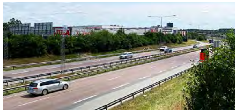
Figur 2.5 E18 är nedsänkt med skärningar på båda sidor av vägen.
