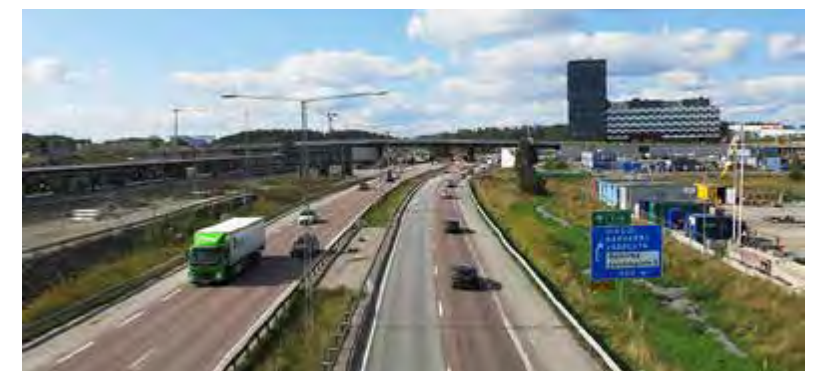
Figur 2.7 E18 och järnvägen skapar en bred infrastrukturkorridor i dalgången där det pågår omfattande förändringar av markanvändningen.
