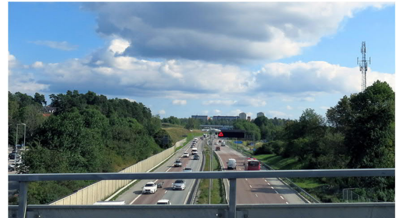
Befintlig bullerskyddsskärm och bullerskyddsvall på östra sidan av E18
