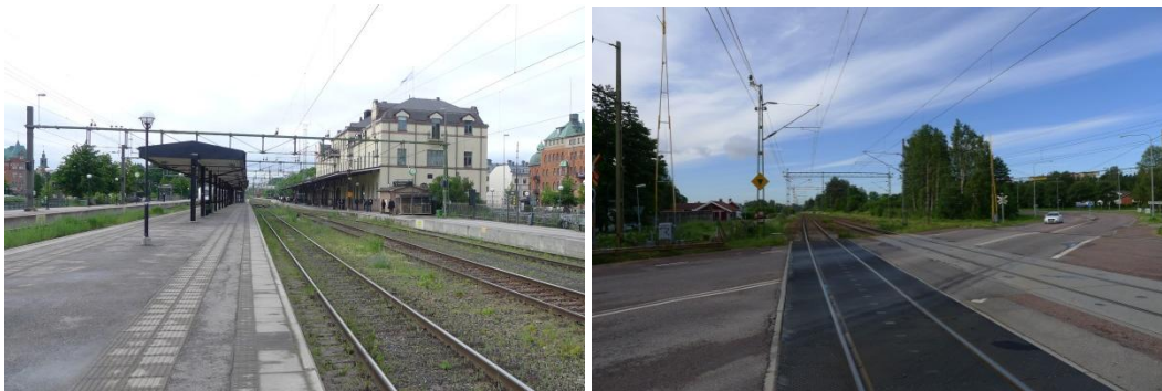
Figur 2.3.6-1 och 2.3.6-2. Till vänster; Gävle Centralstation. Till höger; vägövergång vid Stigslund/Strömsbro.
