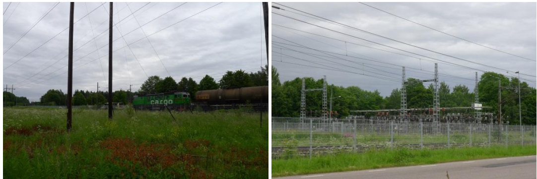
Figur 6.5.2-1 och 6.5.2-2. Till vänster; Bergslagsbanan vid läget för föreslagen ny regionalstågshållplats Gävle Västra. Till höger; Befintlig transformatorstation i Lexe vid föreslaget läge för Gävle Västra.
