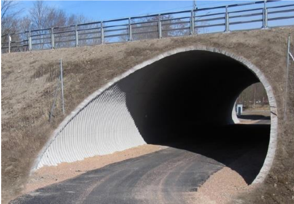
Figur 7. Exempel på rörbro där röret är snedskuret för att skapa enbättre ljusförhållanden i tunneln. Rörets kant är täckt med betongsten för att skapa ett tydligt möte mot omgivande grässlånt. Foto: ViaCon 2009, (bilden har redigerats).
