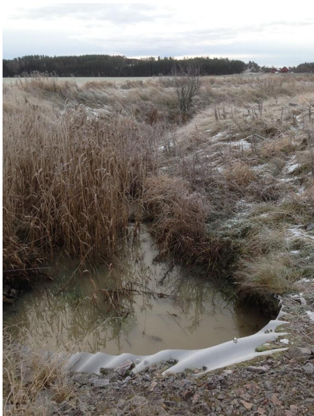
Figur 7. Furingstaån, uppströmssidan om rörbro för väg 881.
