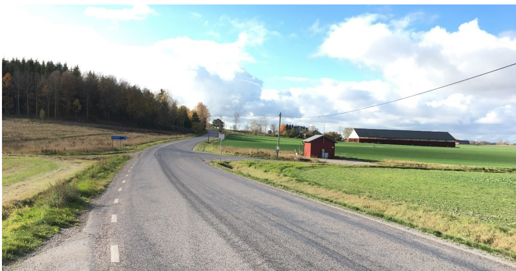
Figur 16 Korsningen vid vägen mot Marby där hållplatserna ska tillgänglighetsanpassas.
