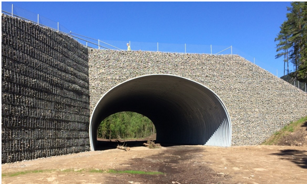
Figur 9 Gabionmur och rörbro.
