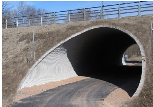
Figur 13 Exempel rörbro (originalbild ViaCon 2009, bilden har redigerats).
