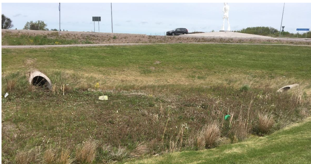
Bild 12 befintlig dagvattendamm sydväst om Hackeforsrondellen
