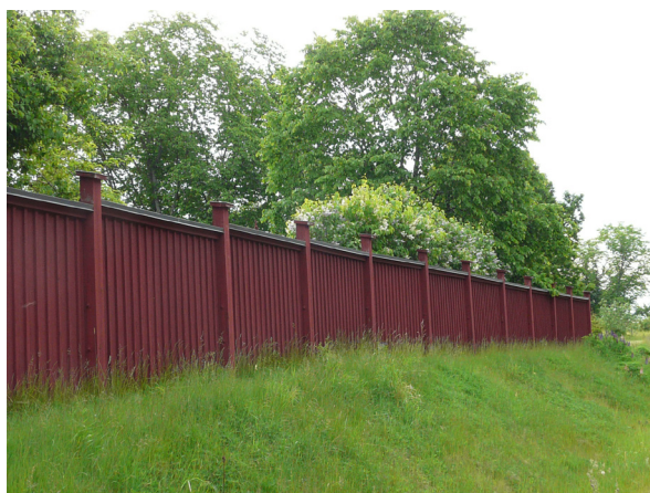
Bild 18. Exempel på enkelt bullerskyddsplank som finns i början av sträckan vid Sandtorpet.
