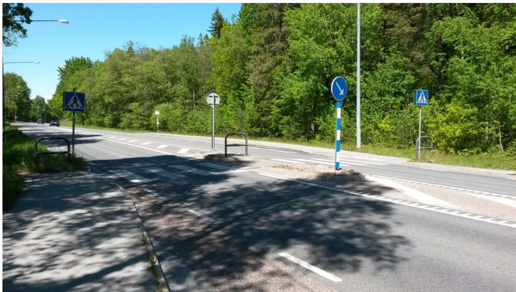
Figur 9. Övergångsställe/passage i plan vid busshållplatsen Jaktsskyttebanan.
