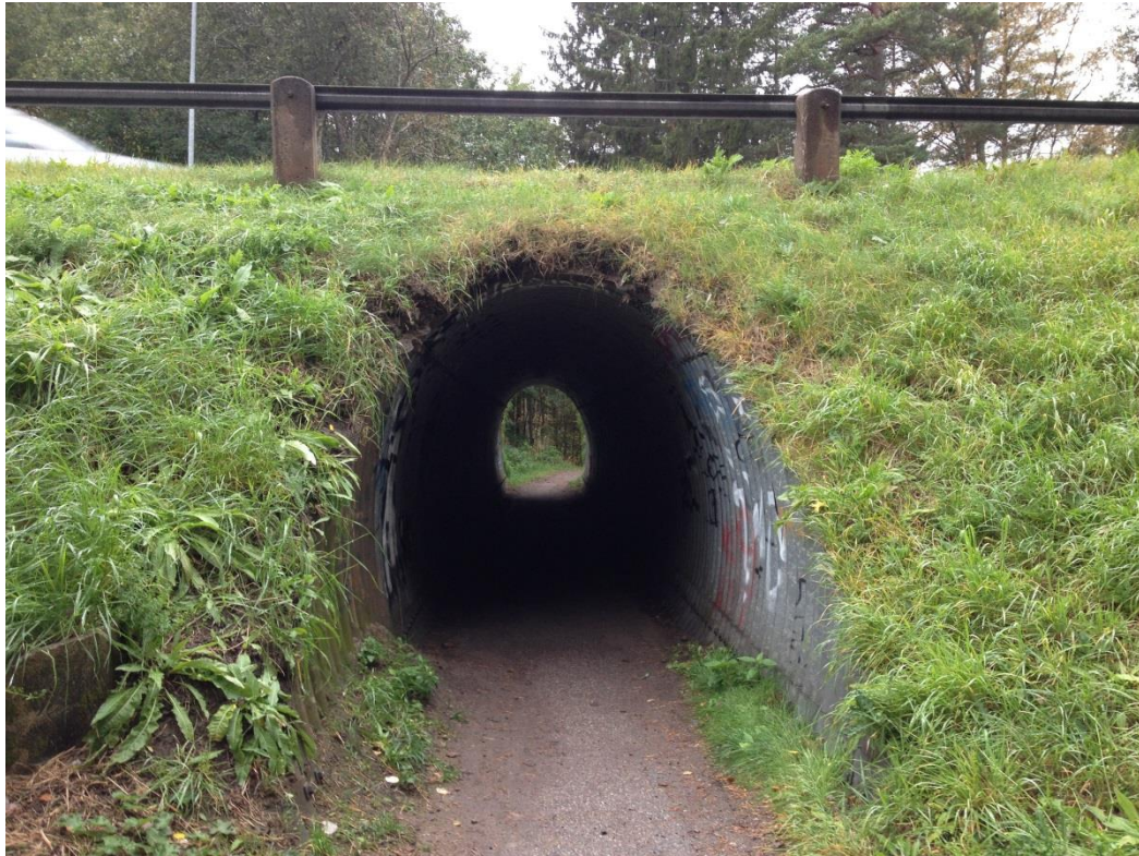
Figur 6. Port under väg 262 vid Rösjöns busshållplats.
