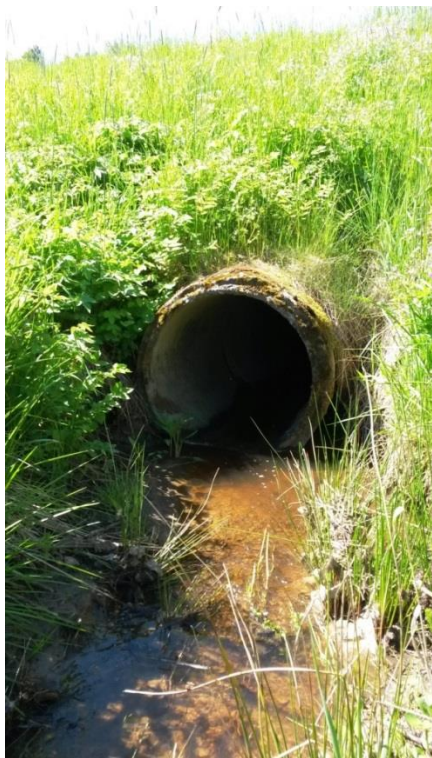
Figur 40. Trumma som leder Sättrabäcken under väg 262 (nordvästra sidan av vägen).
