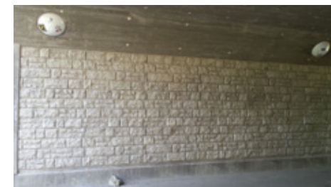
Väggarna i den befintliga GC-porten vid Lomvägen-Fasanvägen har gjutits mot en matris som efterliknar naturstensbeklädnad.
