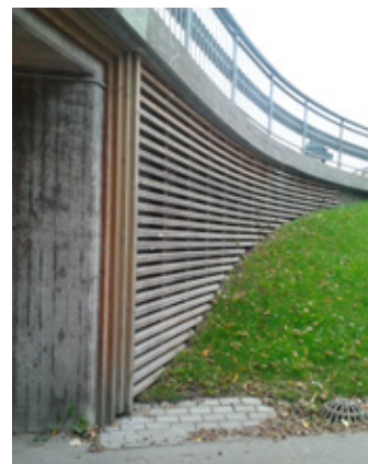
Väggarna i den befintliga GC-porten vid Lomvägen-Fasanvägen har gjutits mot en matris som efterliknar naturstensbeklädnad.
