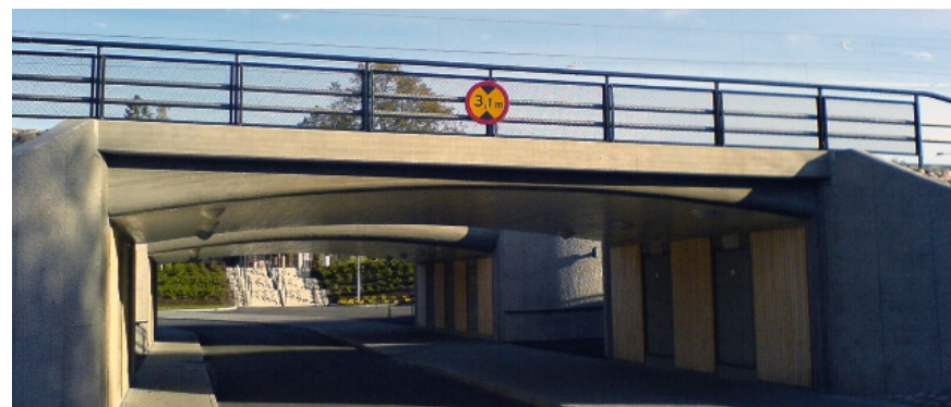
Exempel på broräcke med nätgrind (fmk.se).
