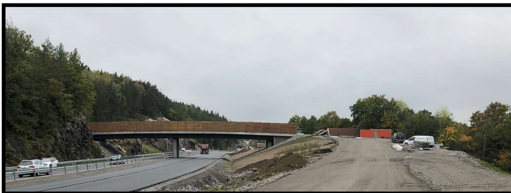
Figur 14. Det nyanlagda Högelidsmotet. Gång och cykelvägen är planerad att lokaliseras norr om rampen upp mot det norra brofästet. Sett mot Tollered. Foto: Mika Määtä
