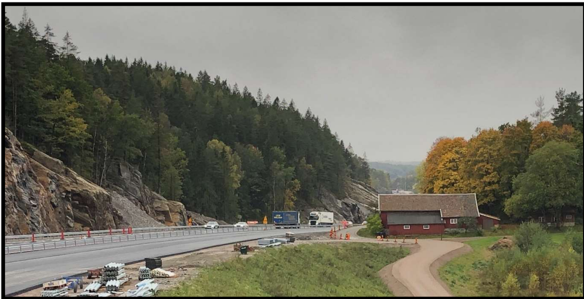
Figur 12. Vid Tolleredskog kantas E20 både av kraftig bergskärning och av gammalt kulturlandskap. Sett mot Tollered. Foto: Mika Määttä
