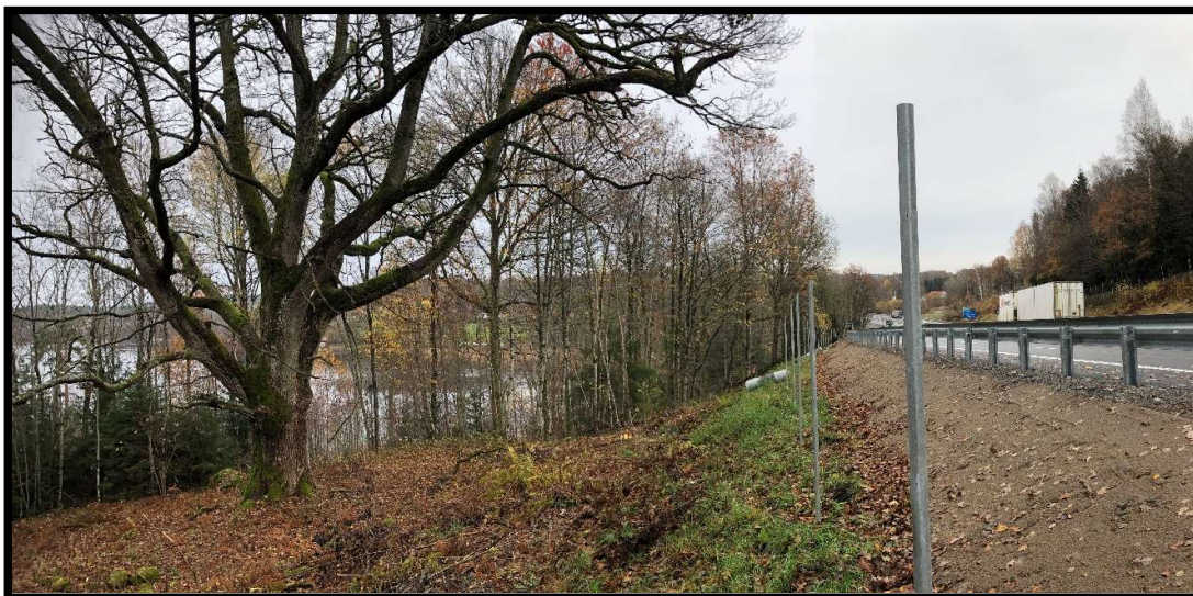
Figur 35. Gång- och cykelvägen byggs som utvidgning av motorvägen vid slänterna mot sjön. För att minska markintranget kompletteras slänterna med en 1–3 meter hög stödmur. Naturmarken är svårtillgänglig och slyartad men det finns även naturvärden med stora karakteristiska ekar. Foto: Mika Määttä
