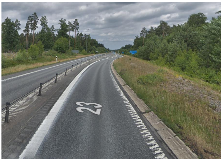
Figur 11: Exempel på sidoförskjutning utanför Ballingslöv (källa: Google maps)
