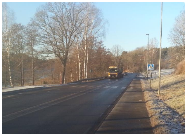
Figur 38: Friliggande övergångsställe på väg 225.
