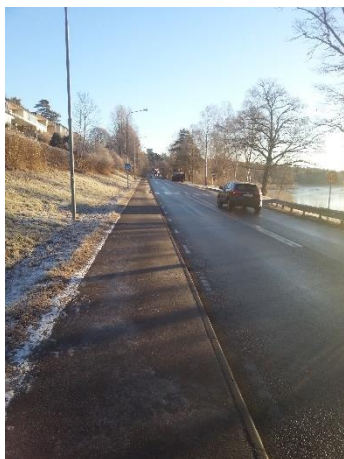
Figur 37: Gångbana längs väg 225
