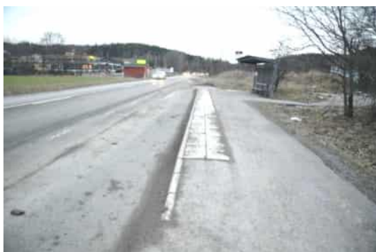
Busshållplatsens utformning och anslutande gångbana.
