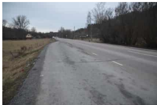
Sikt åt vänster med smal vägren. Vägpassage vid busshållplatsen.
