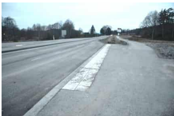
Busshållplatsens utformning samt sikt åt höger.
