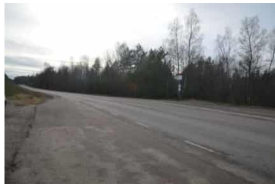
Sikt åt vänster med anslutande utfarter på båda sidor om vägen.
