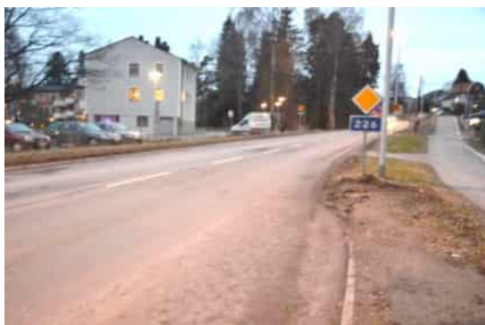
Sikt åt höger samt anslutande gångbana.
