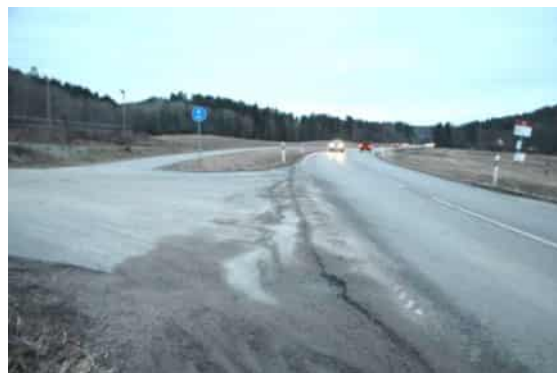
Sikt åt vänster samt anslutande gångbana.
