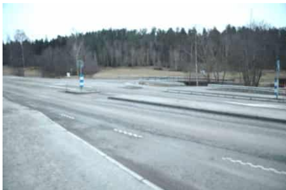
Vägpassagen med mittrefug.
