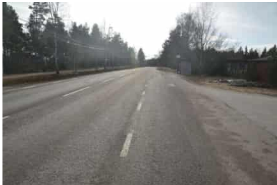
Busshållplatsens utformning invid utfart till bygghandel.
