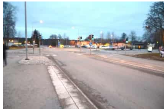
Sikt åt vänster och vägpassage vid busshållplatsen med signalreglerat.
