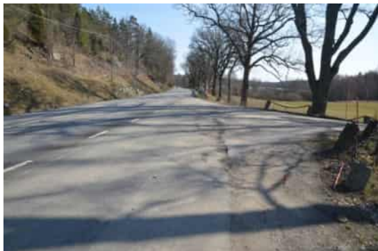
Sikt åt höger med anslutande utfart.
