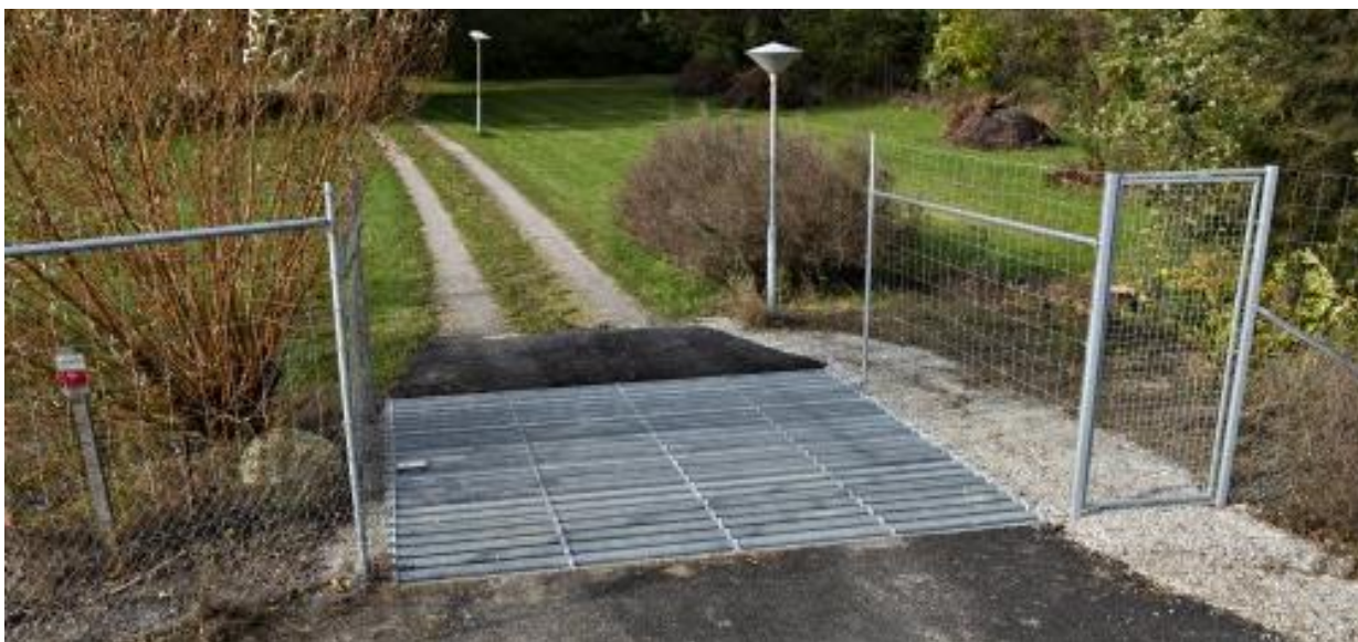
Figur 22. Viltstängsel anslutet till färäst vid enskild väg med anslutande sidogrind för exempelvis passage med husdjur. (LHFENCE, 2020).
