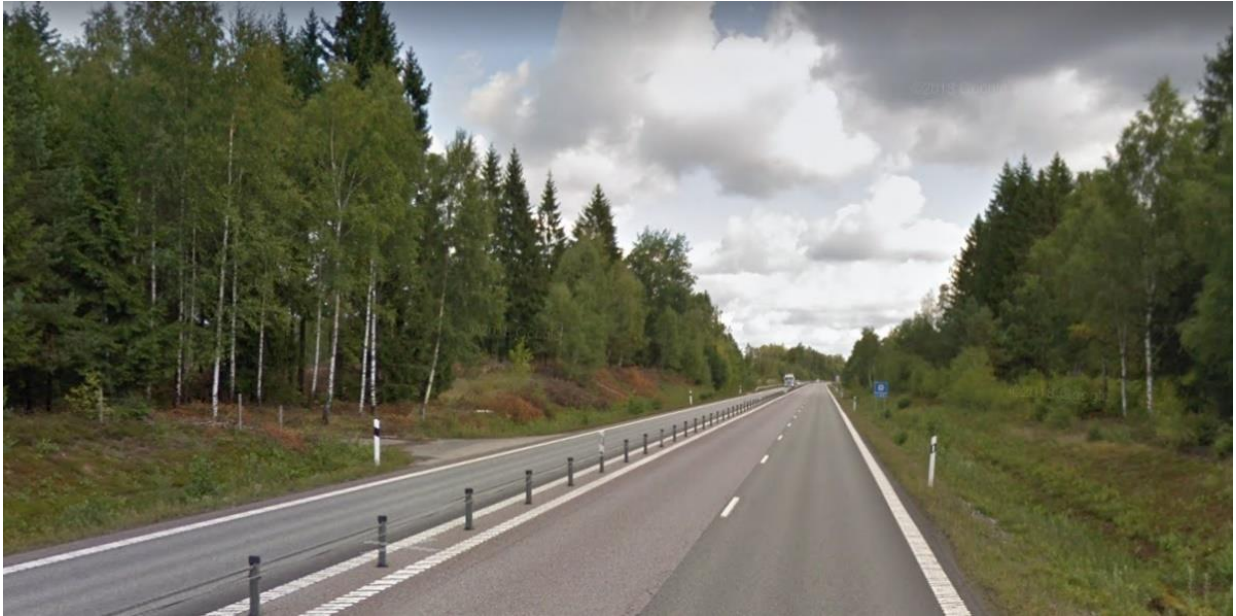
Figur 15. Aktuell vägsträcka för passage 2a. Bilden är tagen norrut.
