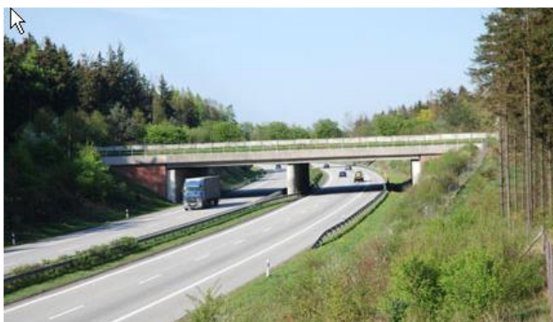
Figur 18. Faunabro med vegetation. Foto Trafikverket.
