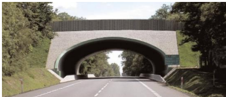
Figur 7. Exempelbild på stålvalvsbro (SuperCor).
