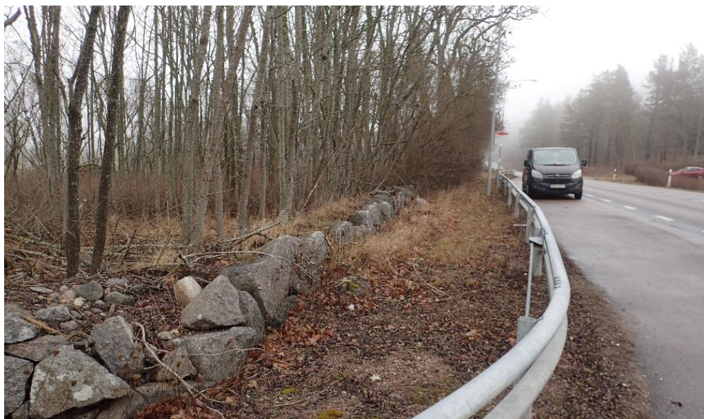
Figur 8: Längsgående stenmur, sektion 3/760
