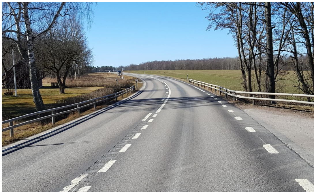
Figur 2: Väg 919. Vägen har smala vägrenar och längsgående räcken. Trafiksäkerheten för gång- och cykeltrafikanter är låg.
