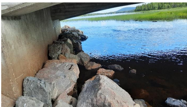
Figur 8 Strandpassage vid befintlig vägbro i Skaulo
