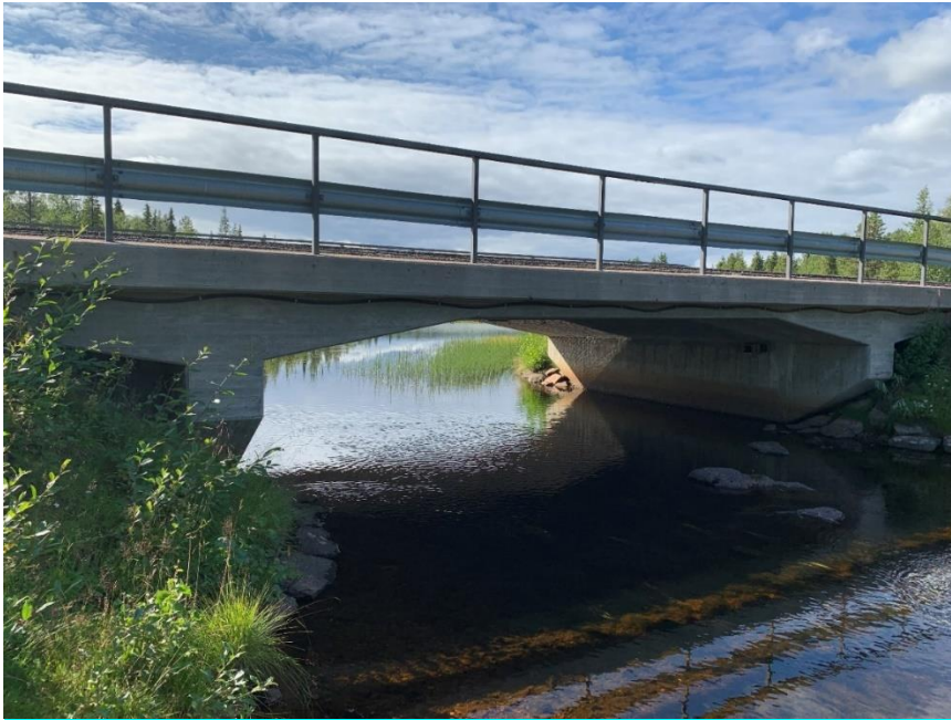
Figur 3 Befintlig bro över Kivijoki
