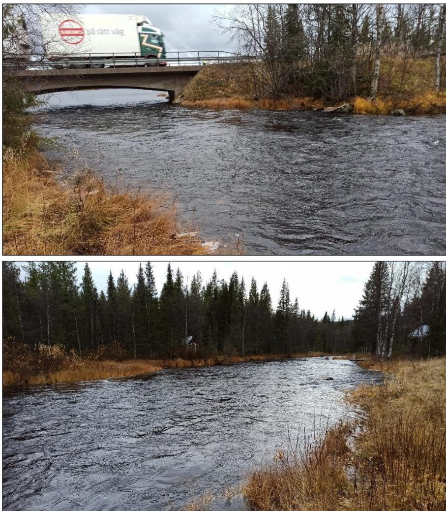
Figur 8. Vattendragssträckan nedströms bro 25-132.1. Det övre fotot är taget i riktning uppströms och det nedre fotot är taget i riktning nedströms. Längs denna sträcka ansattes Mannings tal i tvärsektionerna till 25 \text{ m}^{1/3}/\text{s} . Foto: Robert Rachwalski, Sweco Polen.
