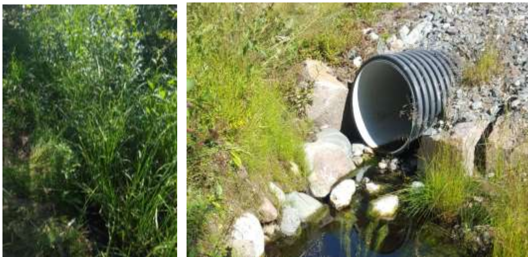
Figur 16 och 17 visar dikets utseende nedströms trumman under väg E 10. Diket är helt igenväxt och vattenflödet genom trumman nästan obefintligt.
