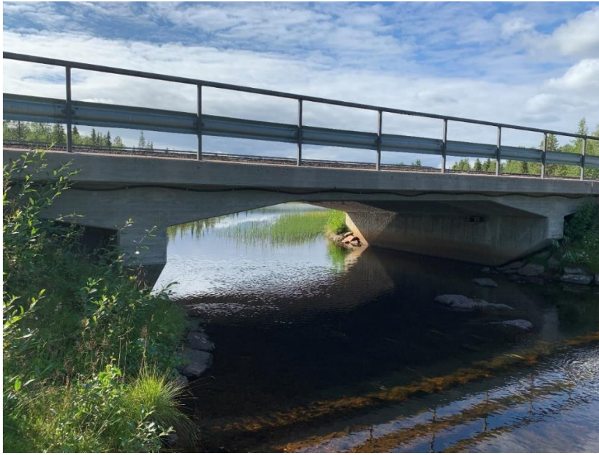
Figur 3 Befintlig bro över Kivijoki
