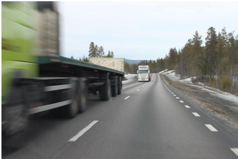
Figur 2. Tunga fordon trafikerar den aktuella vägsträckan. (Foto: Trafikverket)
