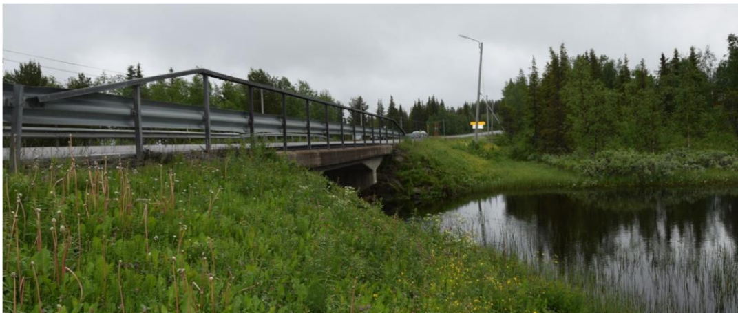
Figur 24. Befintlig vägbro över vattendraget Kivijoki vid Kivijärvis utlopp vid Moskojärvi. Vy norrifrån över den västra sidan som föreslås breddas.
