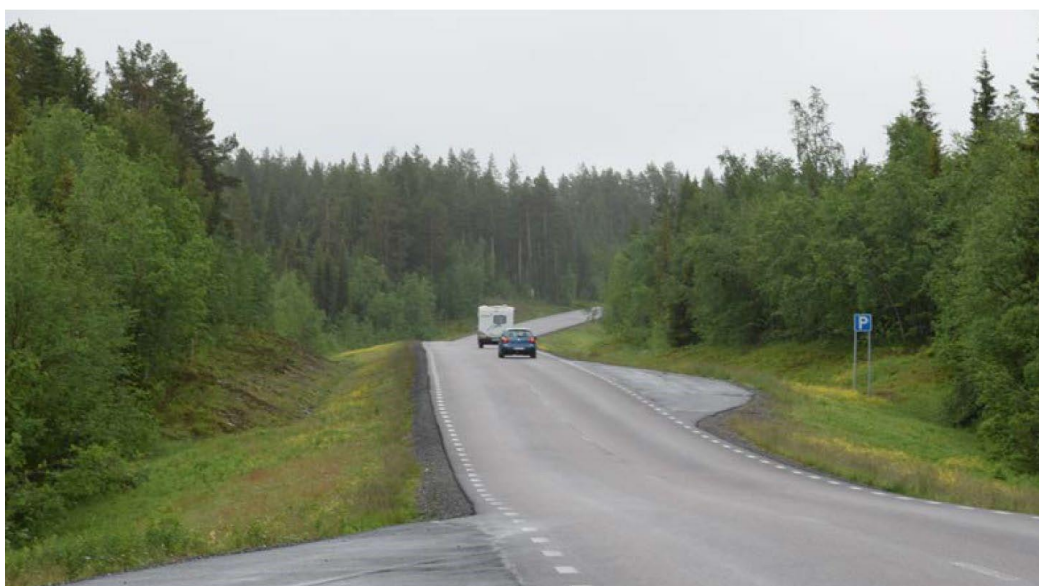
Figur 2. Vy över befintligt vägrum med flacka grästäckta innerslänter där befintlig vegetation ansluter i bakslänts släntröner. Befintlig plan och profil bidrar till att upplevelsen av vägrummet delas upp i sektioner för trafikanten och stundtals begränsar sikten.
